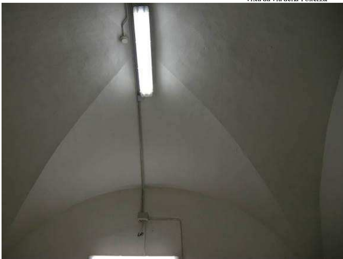
foto n. 11 – esempio copertura a volta.
