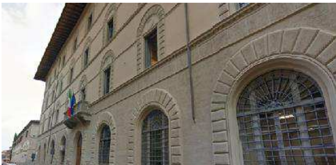
foto n. 2 – facciata principale – via della Fortezza
