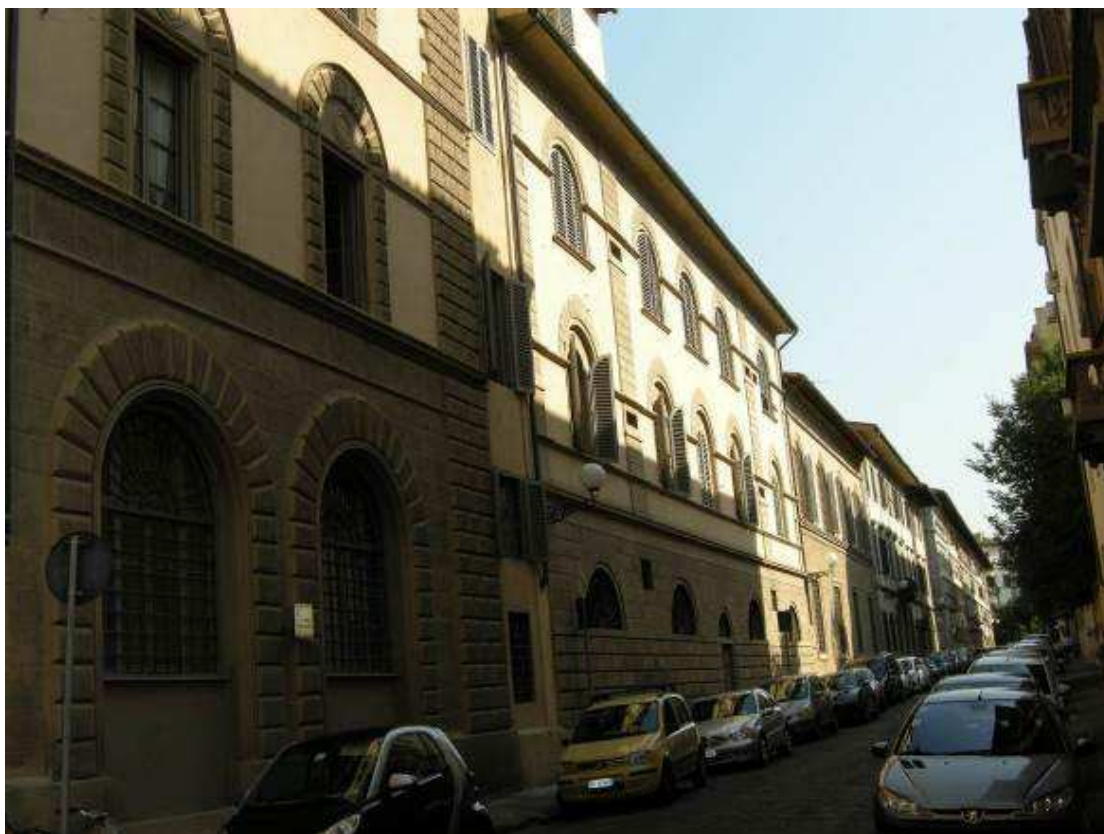
foto 6 – vista da via della Fortezza dei tre corpi di fabbrica su via di Barbano
