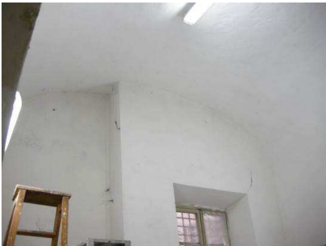
foto n. 12 – esempio copertura a volta
