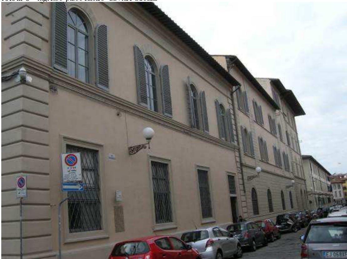
foto n. 9 – facciata lato via del Pratello – vista da viale Strozzi.
