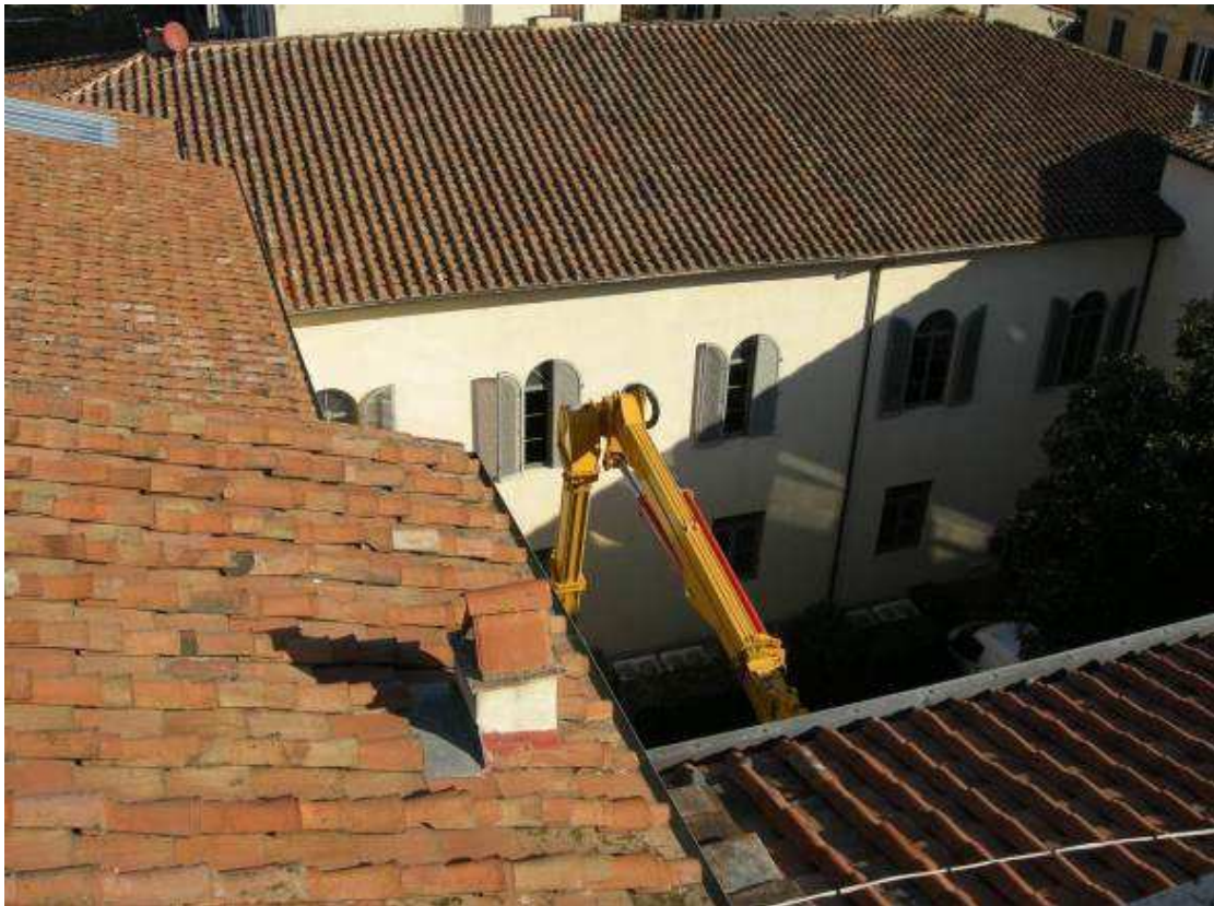
foton. 3 – vista delle coperture e del cortile interno dal terrazzino angolo via della Fortezza/via del Pratello.
