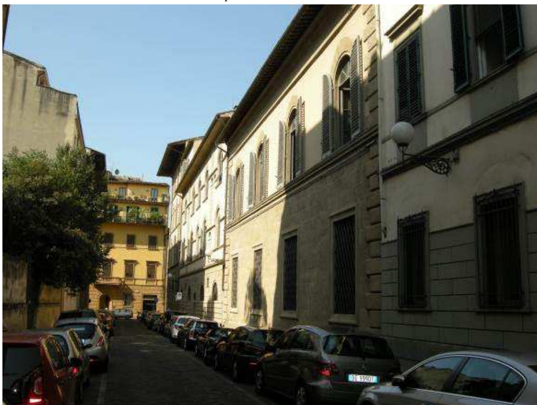
foto 7 – vista da via Ridolfi dei tre corpi di fabbrica su via di Barbano
