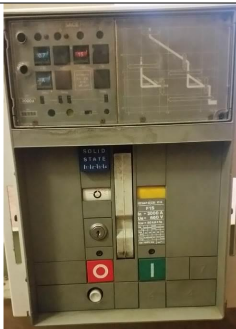
Interruttore a carrello a servizio del rifasatore automatico
