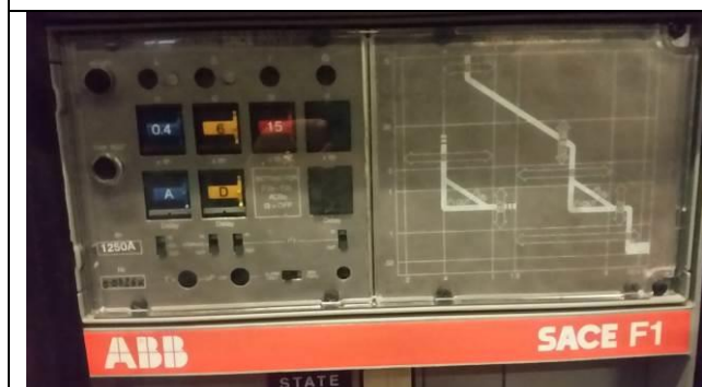
Interruttore a carrello a servizio del sistema di commutazione rete normale/preferenziale - unità di protezione
