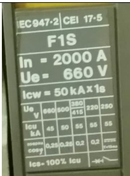
Interruttore a carrello a servizio del rifasatore automatico – dati tecnici
