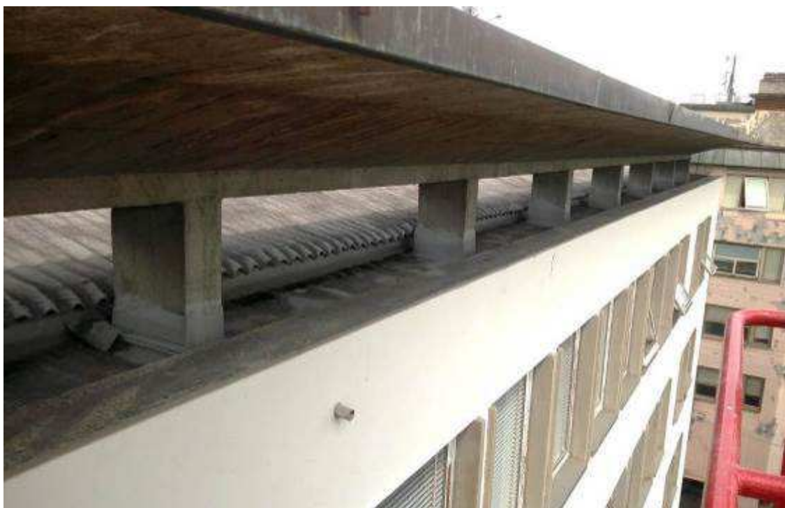
Dettaglio gronda in cls.a. della parte a torre
