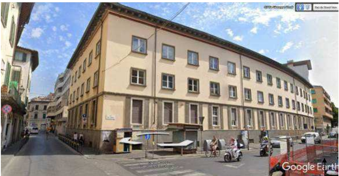
Vista angolo Via Verdi – Via dell' Agnolo
