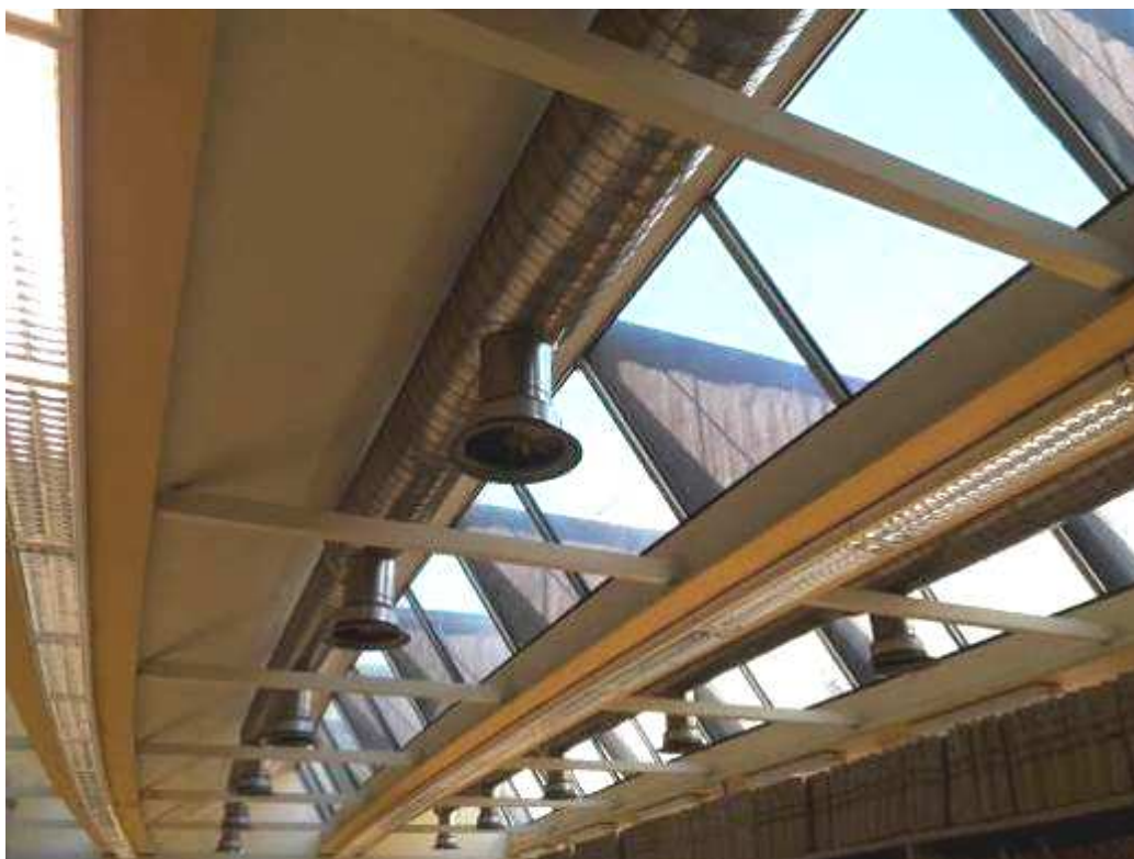
Copertura del salone dall'interno
