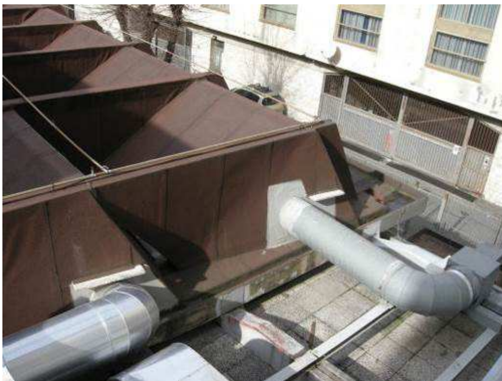
Copertura shed del Salone Visure (S VV) e parte piana di copertura.
