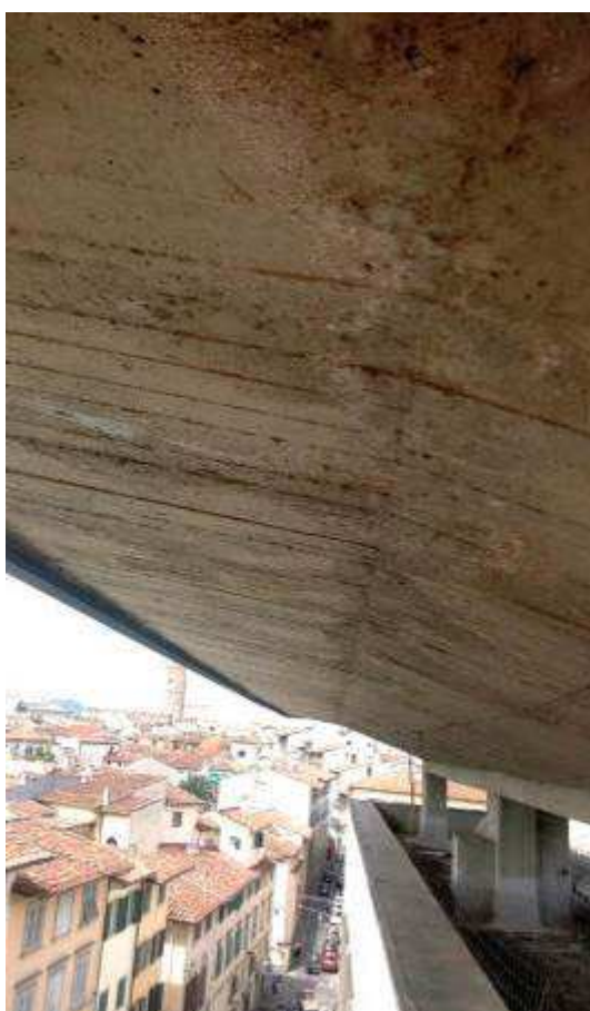
Dettaglio gronda in cls.a. della parte a torre
