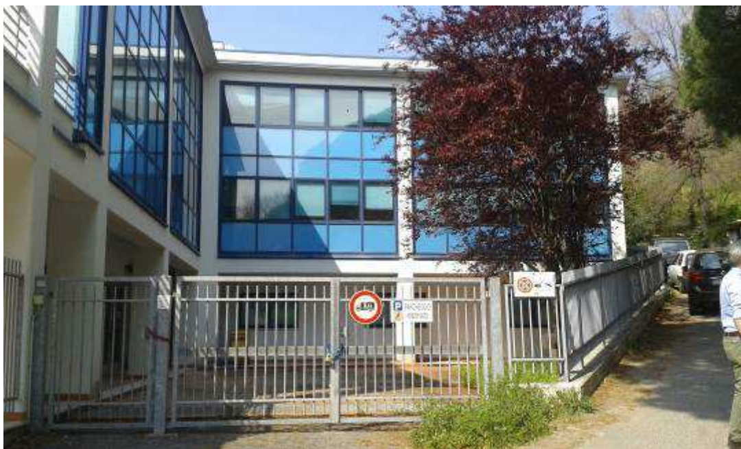
foto n. 3 – ingresso carrabile e pedonale.
