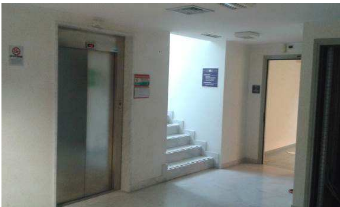
foto 6 – piano terra: vano scala ed ascensore
