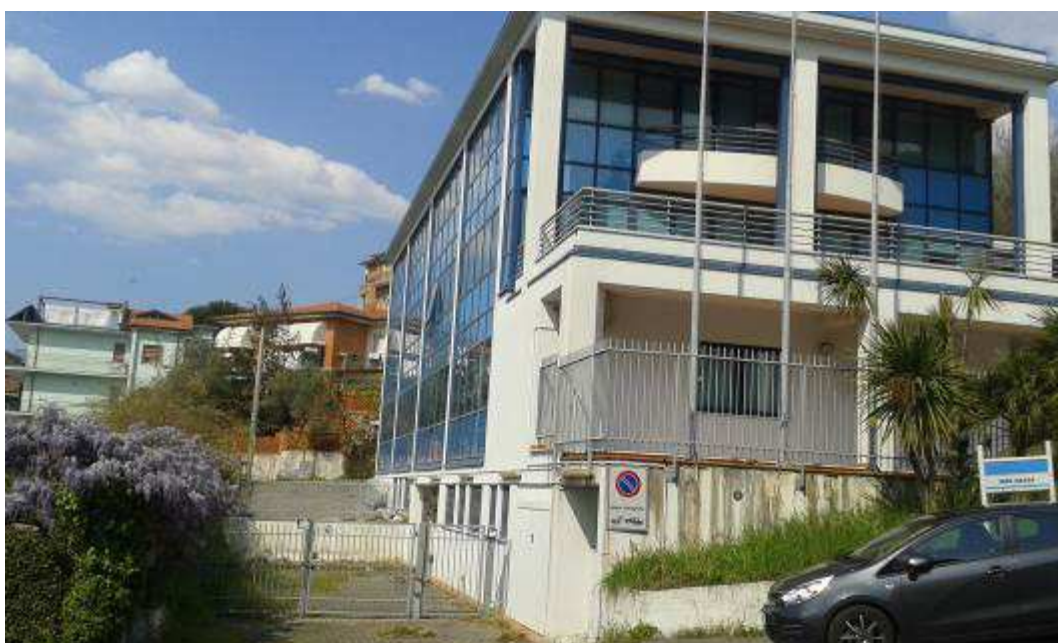
foto n. 2 – facciata principale con vista dell’ingresso carrabile
