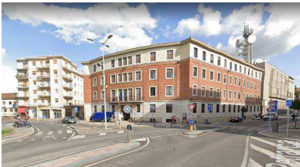
foto n. 2 – facciata principale e prospetto lungo Via Petrarca
